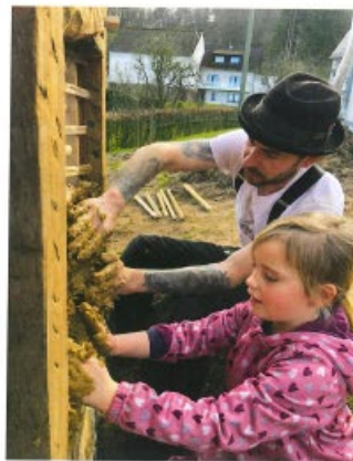
Zimmerermeister Niklas Broos verfüllt die Wände mit Stroh-Lehmgemisch und hat dabei eine talentierte Helferin.
